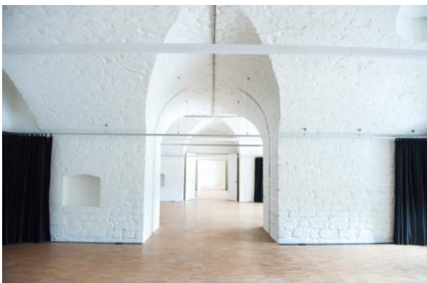
Foto: Durchgang der ausgebauten Räume 1 bis 4, Stadt Ulm
